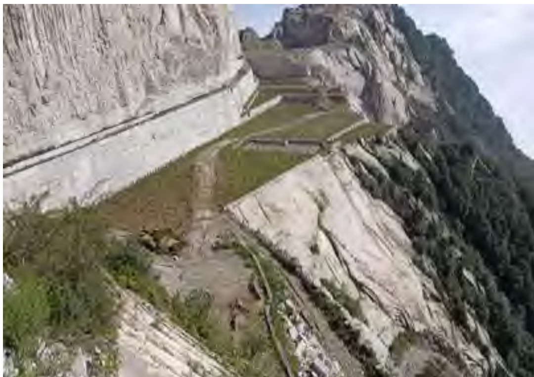
照片 15-2 工程治理后照片
