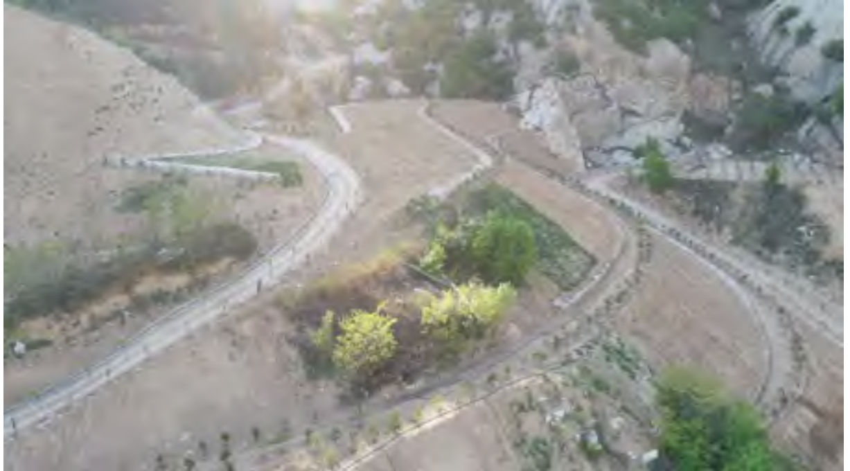
照片 6-2 采场治理俯瞰照片
