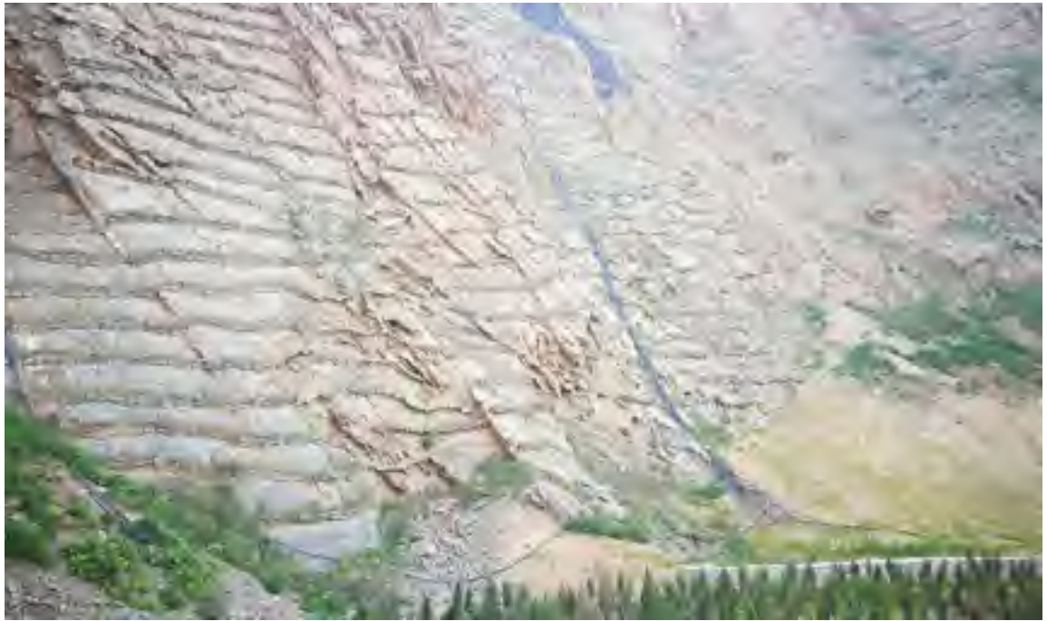
照片 2-1 采场立面治理后照片
