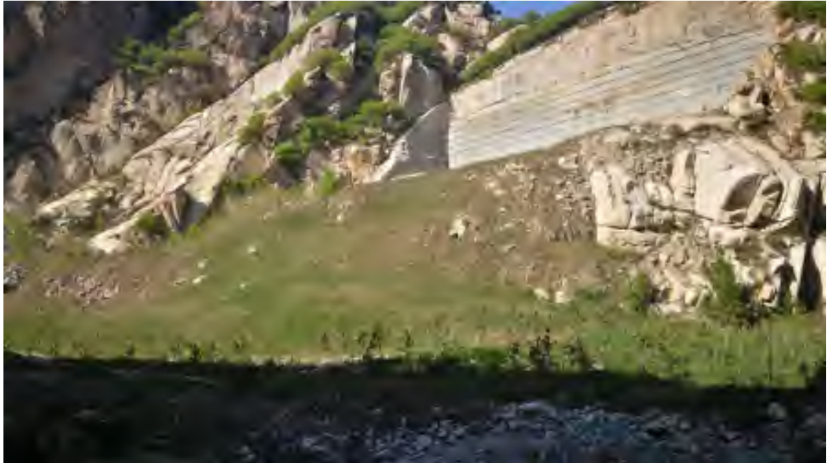
照片 8-2 采场一平台渣堆工程治理后照片
