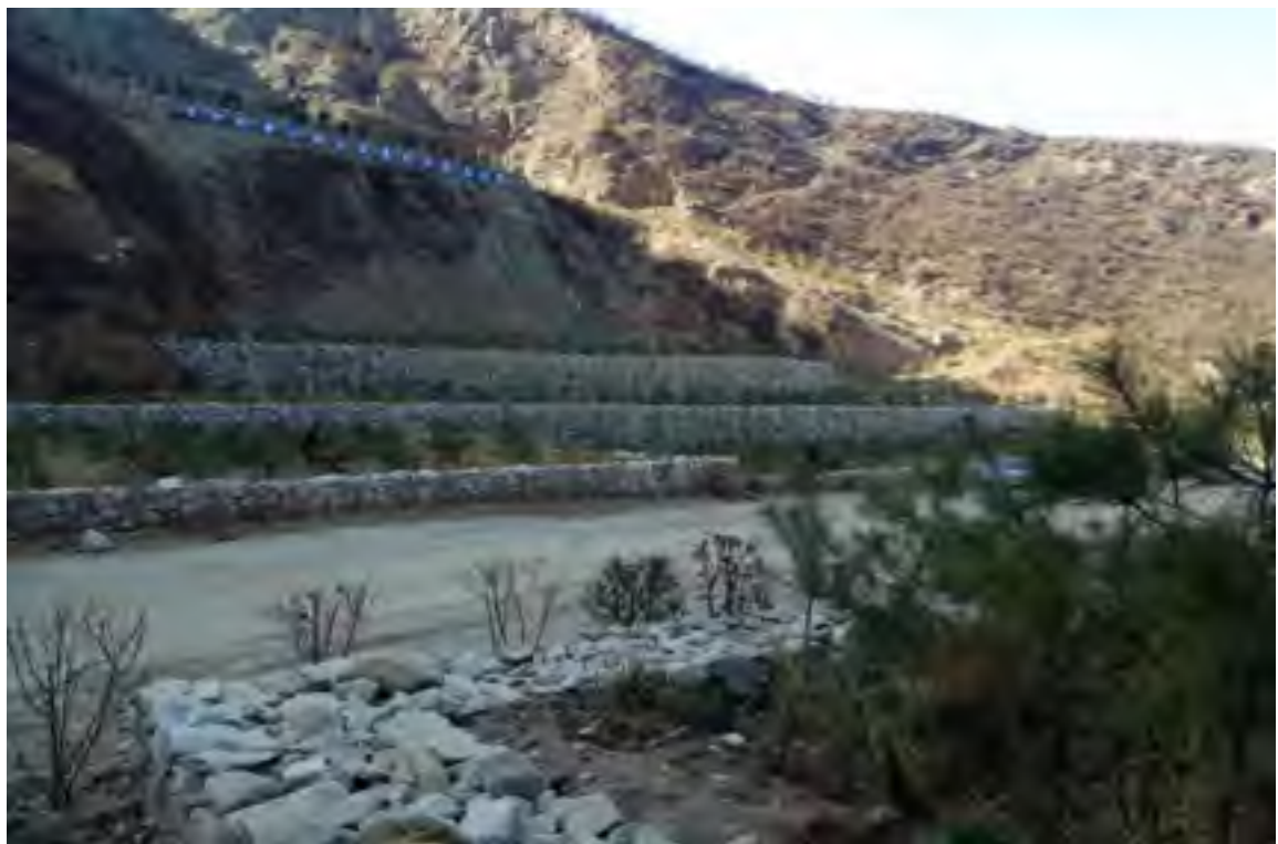
照片 3-2 华阴市方山峪民团石渣厂、方山峪万利石渣厂采场立面工程治理后照片
