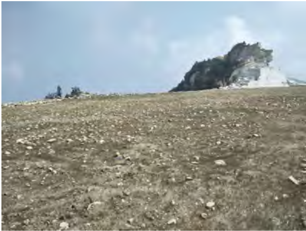
照片 16-1 工程治理后照片
