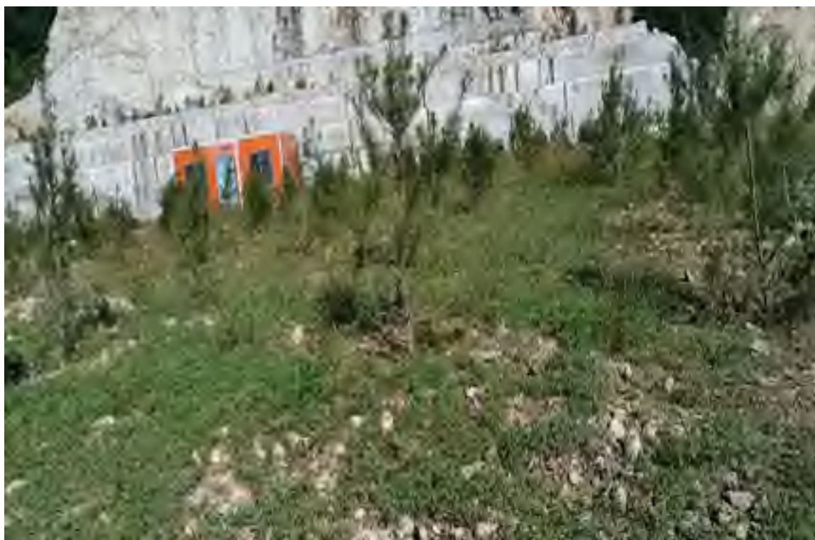
照片 14-2 工程治理后照片
