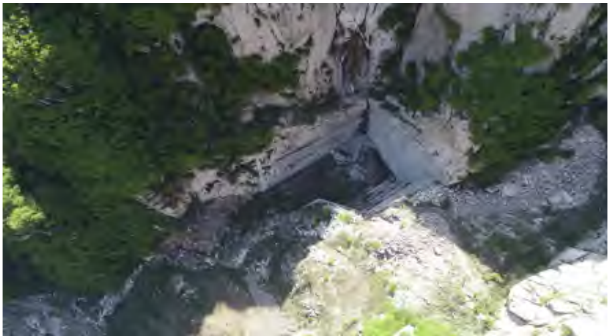
照片 8-4 采场二平台工程治理后俯瞰照片
