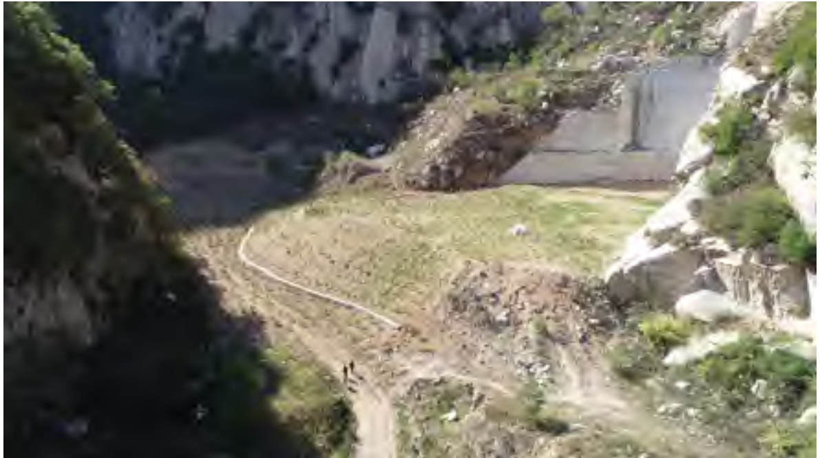
照片 7-1 采场治理后全貌
