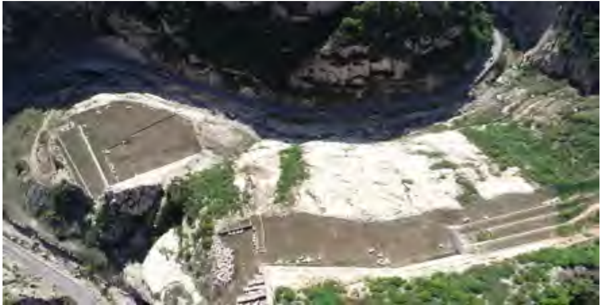
照片 9-1 采场治理后俯瞰照片
