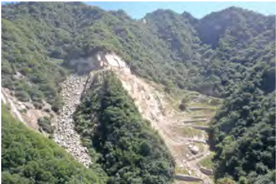
照片 13-2 工程治理后全貌照片 2
