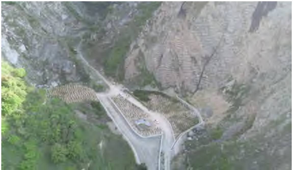
照片 2-2 采场立面及平面工程治理后照片
