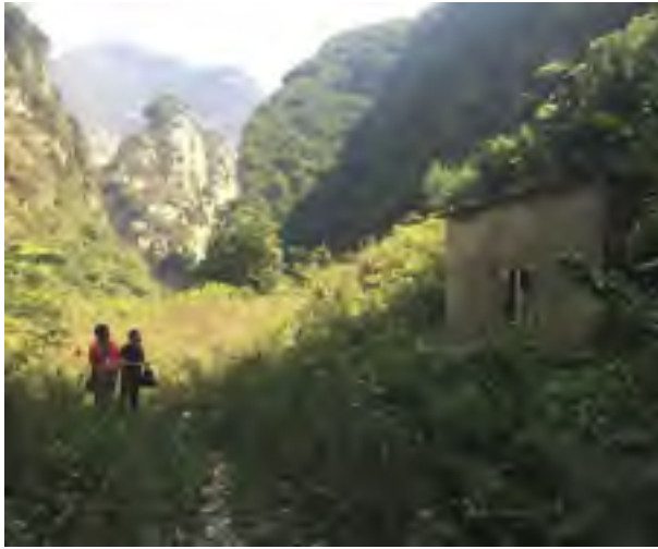
照片 8-06-1 进矿道路口废弃建筑
