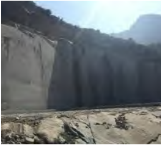
照片 8-03-3 北侧采场
