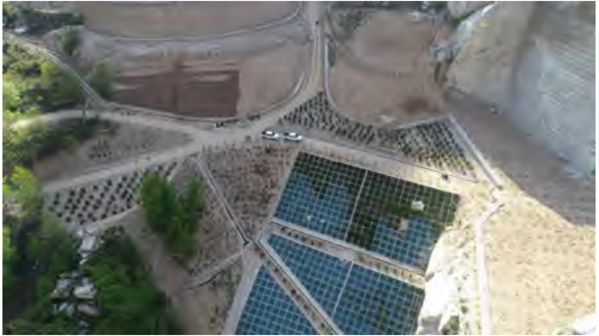
照片 6-1 采场治理俯瞰照片
