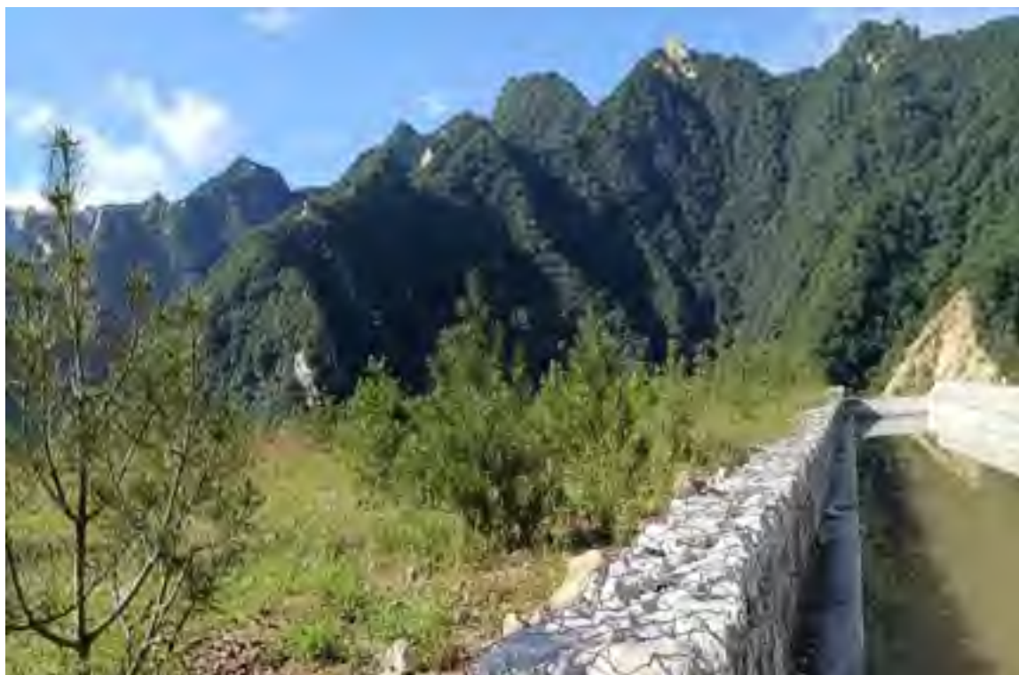
照片 14-1 工程治理后照片
