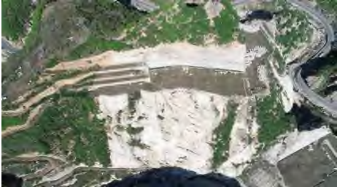
照片 5-1 采场治理俯瞰照片
