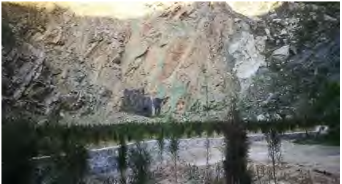
照片 1-2 采场平面工程治理后照片
