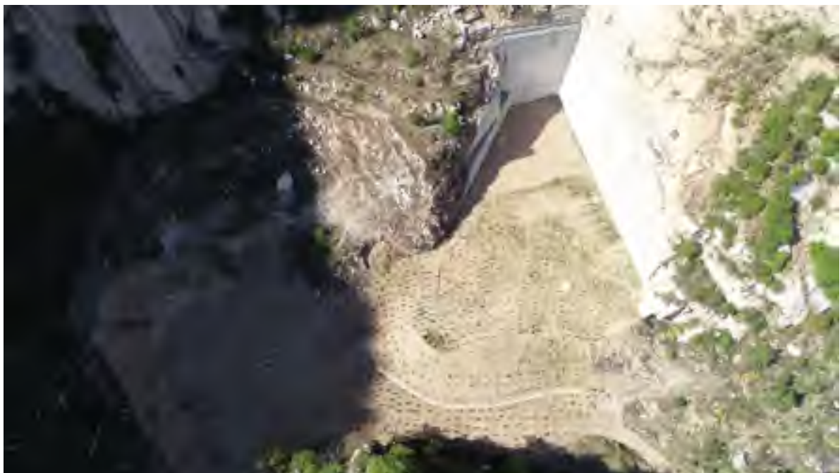
照片 7-2 采场工程治理俯瞰照片
