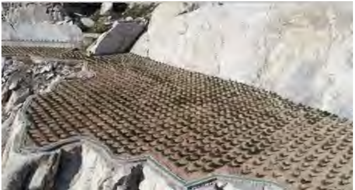
照片 10-2 采场平面工程治理后照片
