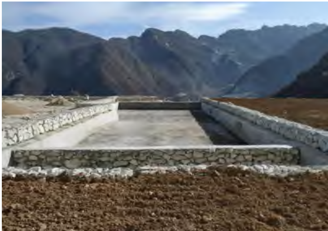
照片 15-1 工程治理后照片
