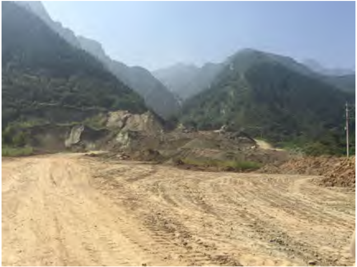
照片 11-3 沟口渣堆正在治理照片（镜向：南）
