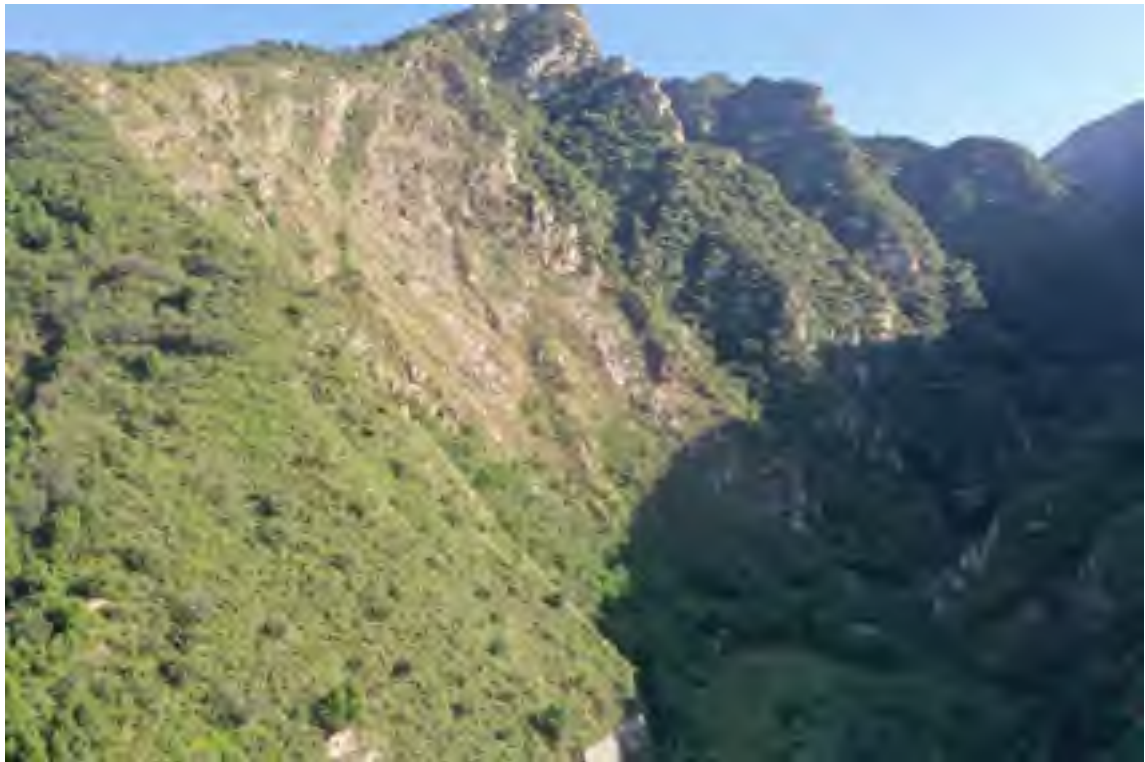
照片 11-1 采场立面治理后照片
