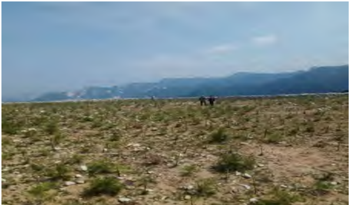
照片 12-5 3 # 采场平面工程治理后照片
