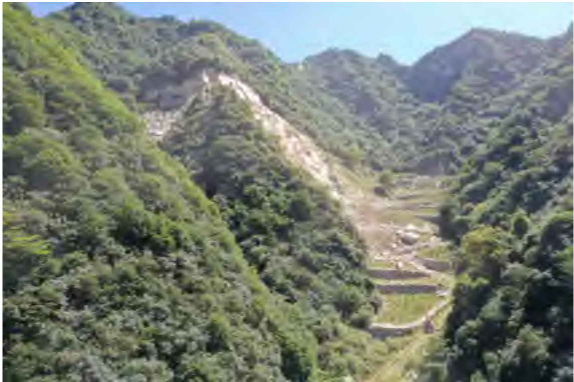
照片 13-1 工程治理后全貌照片 1
