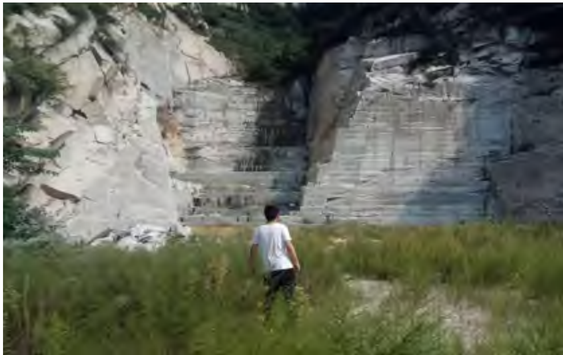
照片 4-2 采场平面工程治理后照片
